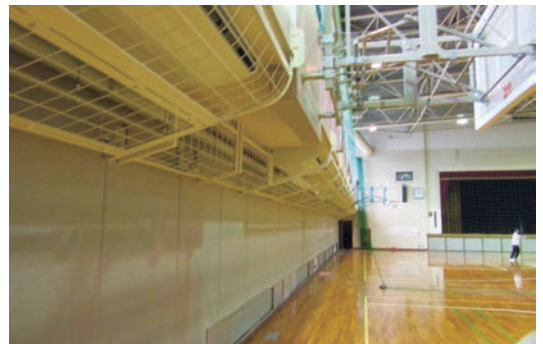
■市立浦和高校体育館に設置されたエアコン
