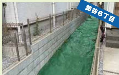
鈴谷6丁目 防草シートの設置
